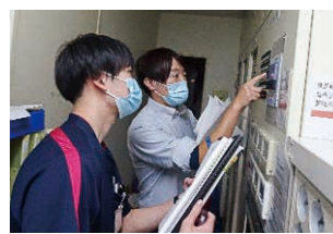
院内電気系統確認
