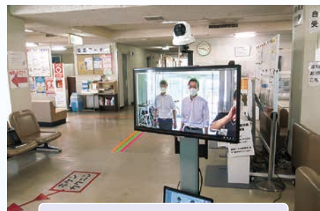
図2 玄関入口に設置したAIサーマルカメラ
